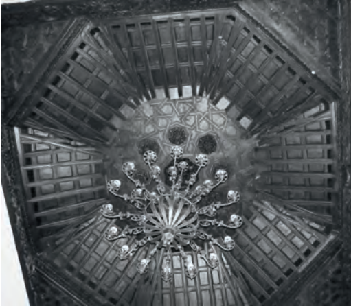
Figura 12 Estructura ochavada que cubre la escalera del Colegio Fonseca, Santiago (imagen del autor)
