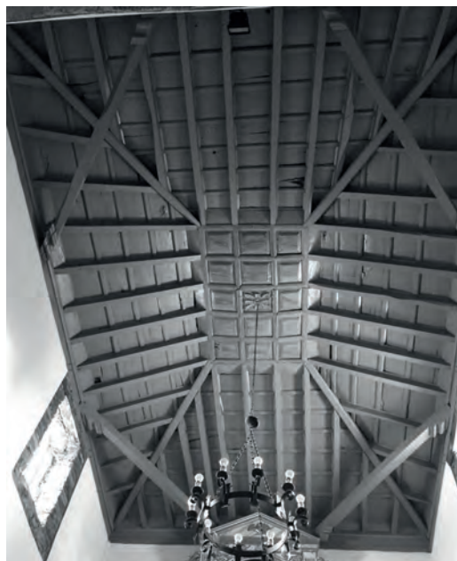
Figura 11 Cubrición de una de las capillas de la iglesia de San Miguel de Mones, Petín, Ourense (imagen del autor) Cubrición de una de las capillas de la iglesia de San Miguel de Mones, Petín, Ourense (imagen del autor)
