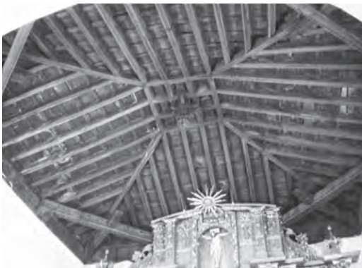
Figura 1 Uso de las limas simples en la cabecera de la iglesia de Lamalonga, A Veiga, Ourense (imagen del autor)
