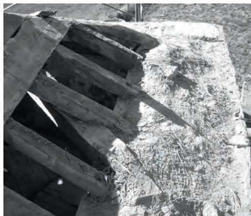
Figura 5 Iglesia de Santa María de Castromao (fotografía de Emilio Busieres). Ejemplo de armadura oculta sobre cúpula, carente de todo sentido estético y primando tan sólo criterios funcionales
