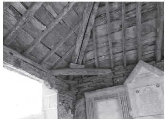
Figura 2 Uso de limas dobles en la arquitectura popular gallega (imagen del autor)
